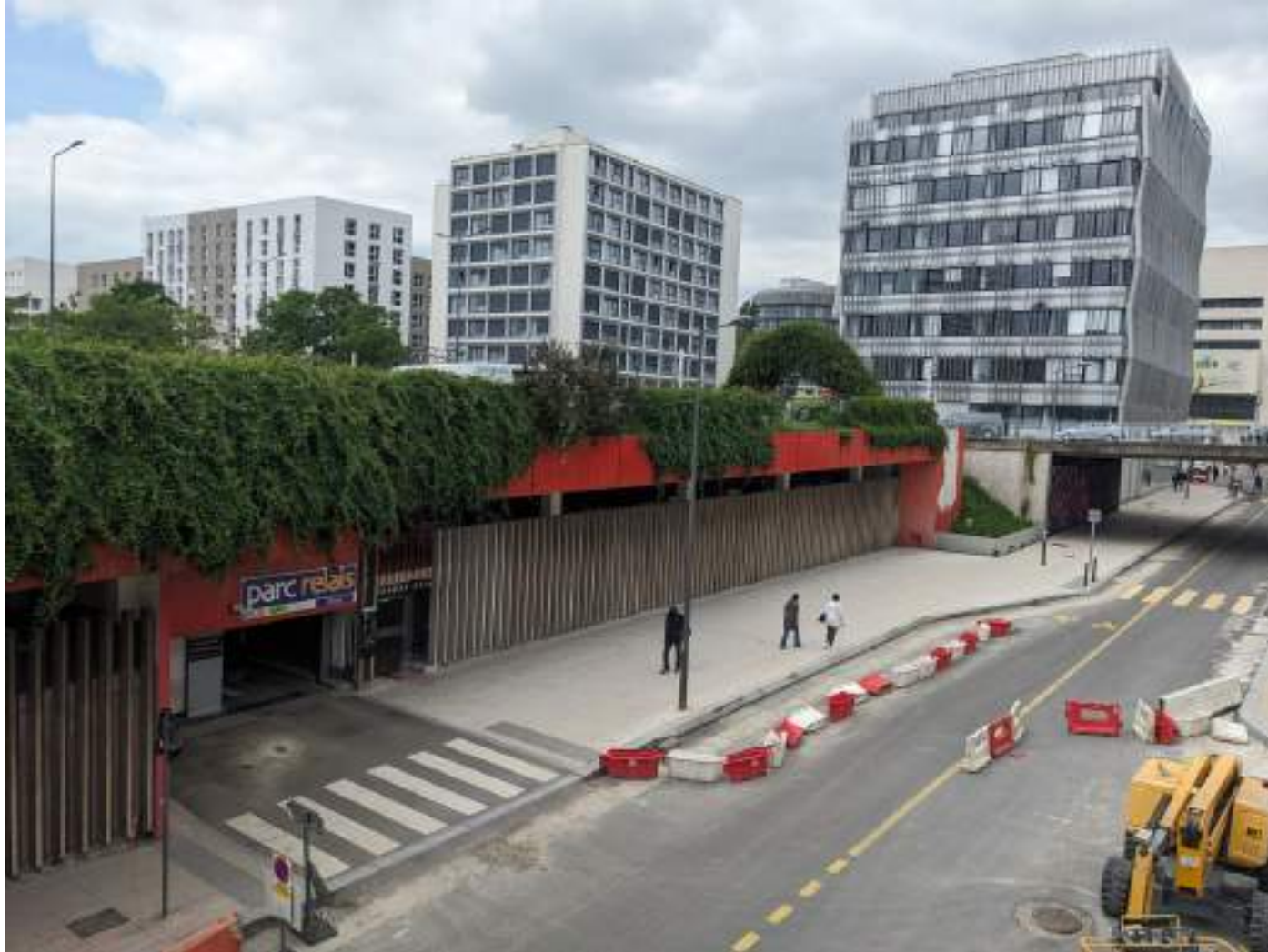
Entrée du parking de l'Oise sous Marché neuf
