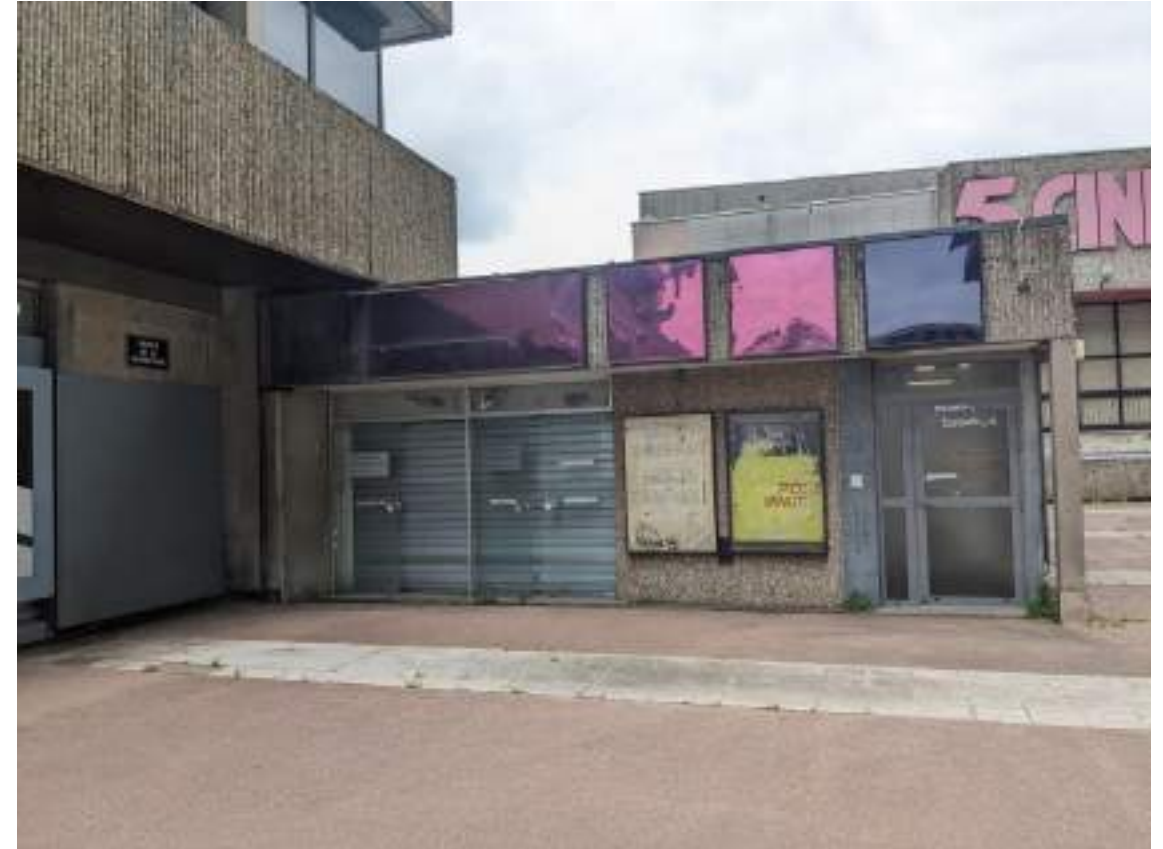
Accès à l'ancienne galerie commerciale et à l'ex RIE de la préfecture
