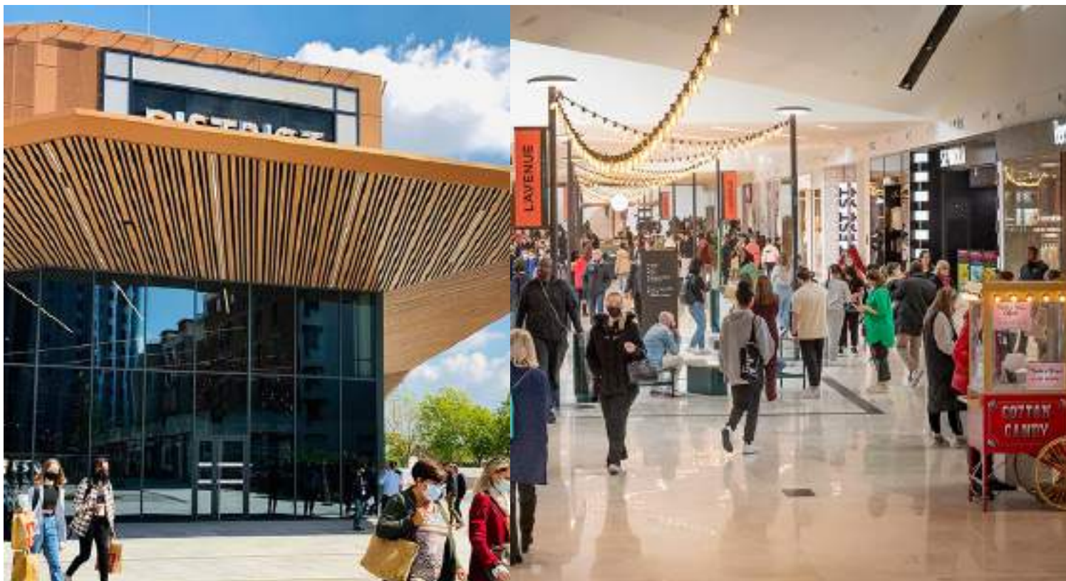
Extension-rénovation du centre commercial régional des 3 Fontaines – livraison : 2022
