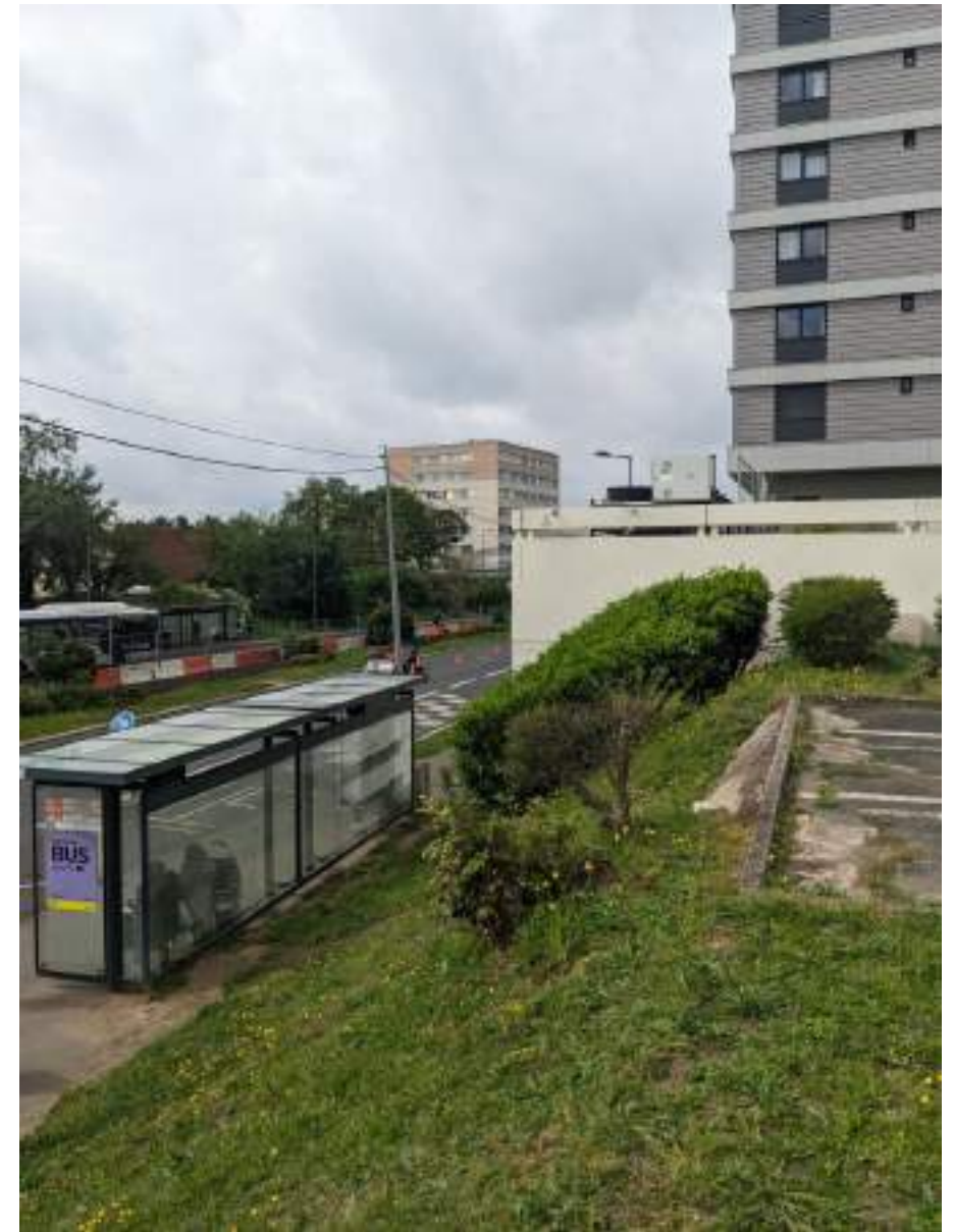
Talus assurant la mise à distance avec l'abribus et le boulevard
